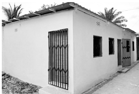
O edifício já pintado, com portas, janelas e grades exteriores.
